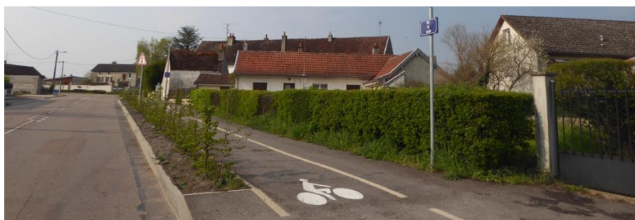
Aménagement d'une piste cyclable à Saulon-la-Rue
