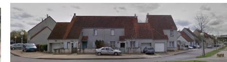
Maisons mitoyennes en lotissement (32 lgts/ha) Chagny
