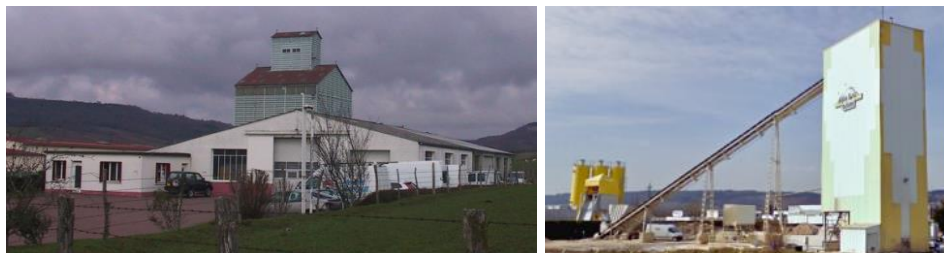
Silos de Nolay et de Dijon Béton à Nuits-Saint-Georges
