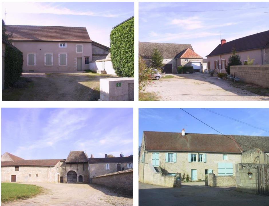
Architectures des villages de Plaine, à la confluence d'influences bressanes (Morteuil, en haut à gauche) et bourguignonnes (Corcelles-les-Arts, en bas à droite).
