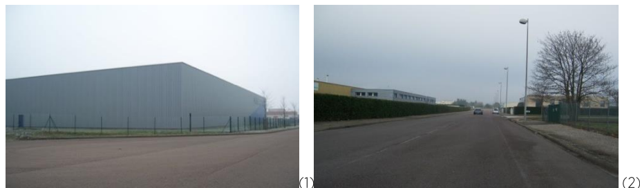
Absence de végétalisation des espaces publics, caractère routier de la voirie à Meursault (1) et à Beaune-Vignoles (2)
