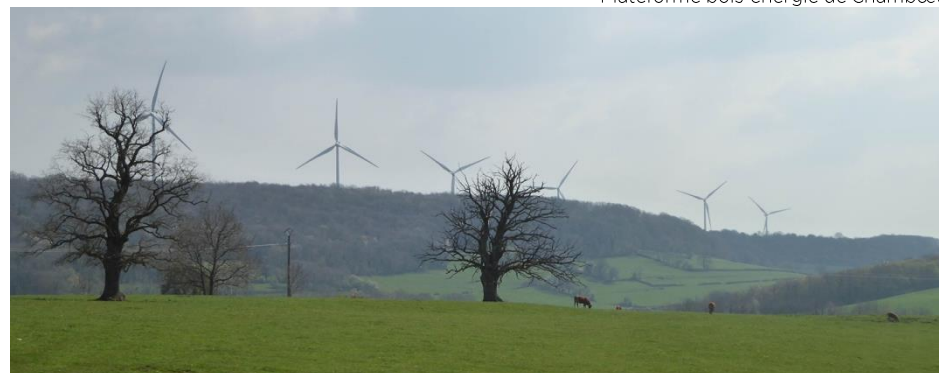
Éoliennes sur les crêtes de Val-Mont
