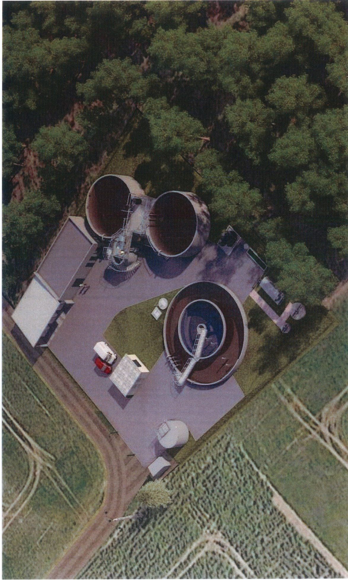
Vue des équipements OTV
