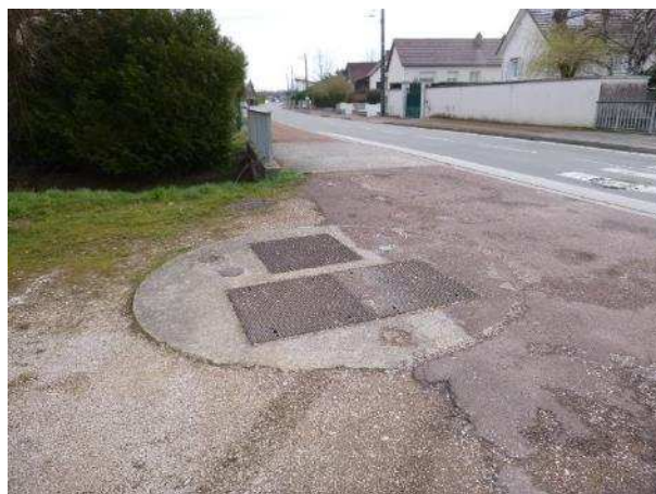
PR Saulon la Chapelle, Salle de l'Union – vue extérieure
