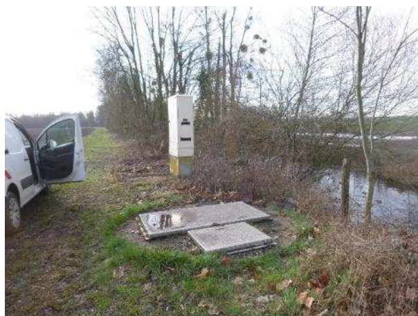
PR Saulon La Rue, La Sans Fond – vue extérieure
