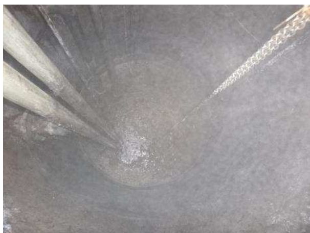
PR Saulon La Rue, La Sans Fond - Puits de refoulement
