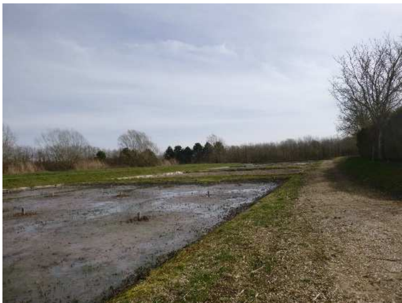
Noiron-sous-Gevrey : Filtre planté de roseaux
