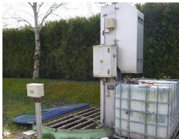
PR UDEP Noiron-sous-Gevrey – Vue extérieure
