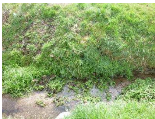
PR Lavoir Exutoire trop-plein
