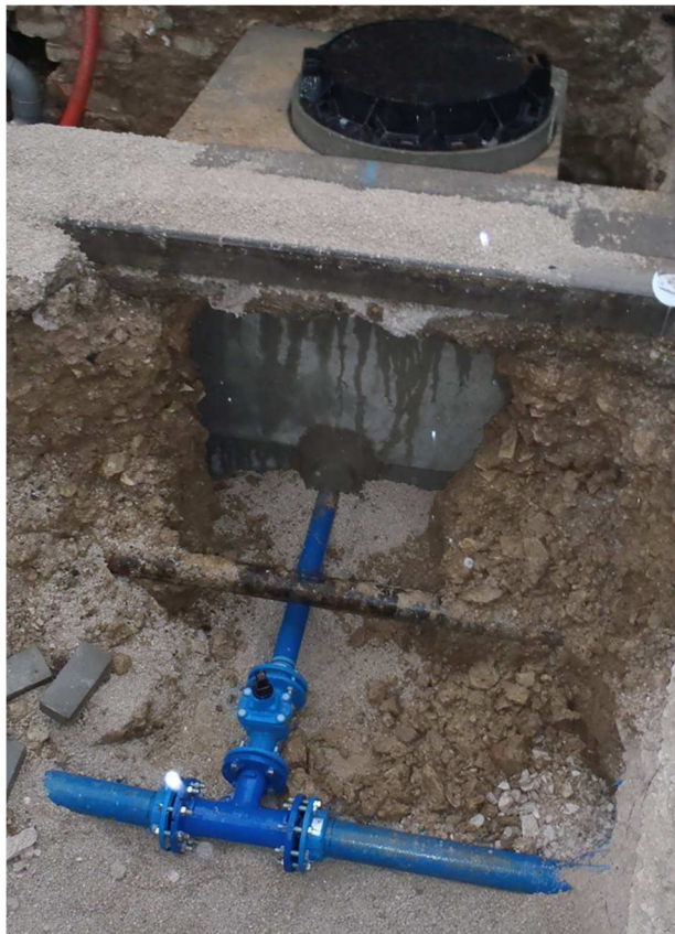
Création branchement d'eau potable
