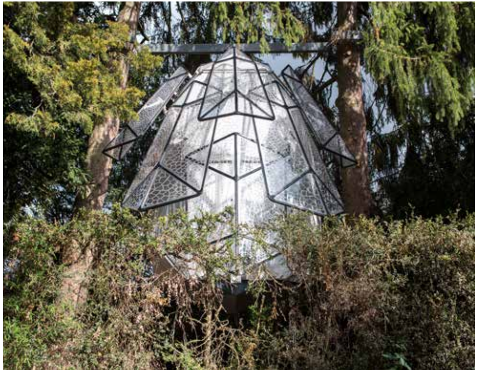
« Le Cabanon Pomme de pin » réalisé pour Jean-Louis Trapet et André Trapet à Gevrey-Chambertin par l'Atelier Zéro Carbone Architectes
