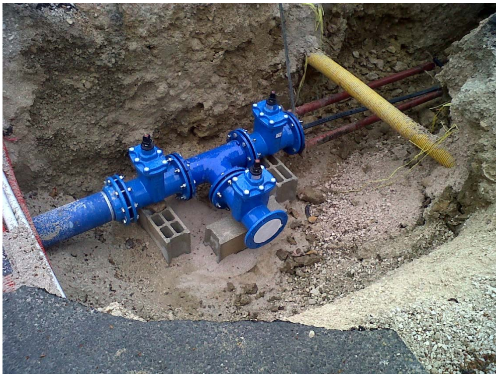
Travaux d'eau potable – Fixin – 2015
