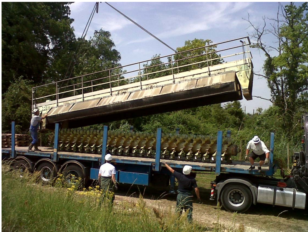
Départ pour atelier de réparation d'une brosse d'aération et de son pont-support STEP de Brochon
